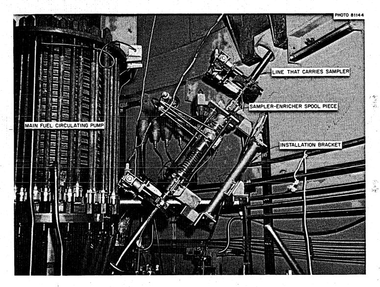
Fig. 24. Installed Sampler-Enricher Spool Piece.
